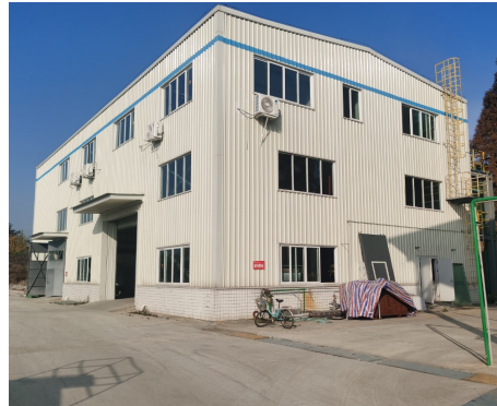
扩建后的维修车间
