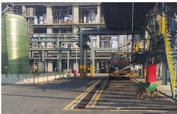
道路旁排水沟
